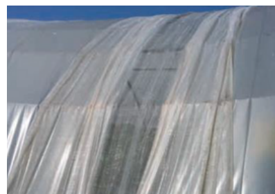
Filet sur un ouvrant de tunnel plastique
